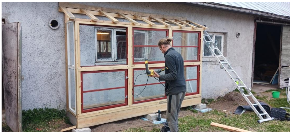
Kasvihuone rakentumassa navetan seinustalle.
